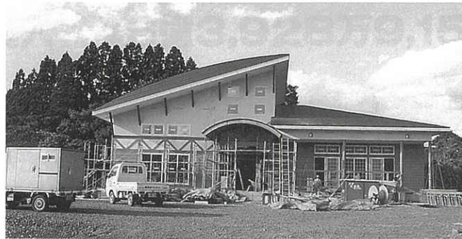
矢坂地区に新たな地区会館を建設中
