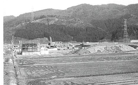
建設中の藤里浄化センター
