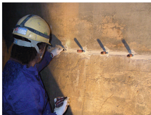
「ひび割れ注入工作業状況」 【他自治体での事例】
