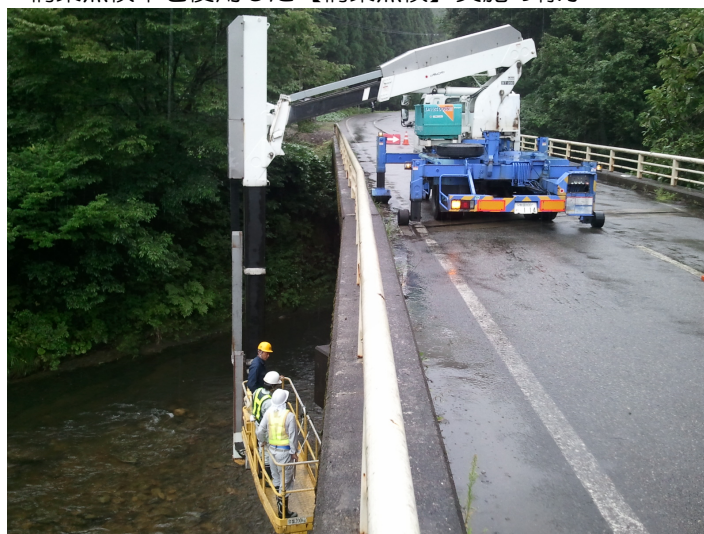
橋梁点検車を使用した【橋梁点検】実施の様子
