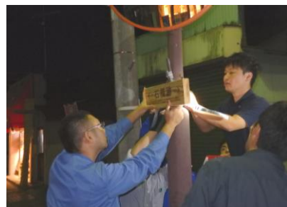
【制作した案内板の設置作業の様子】
