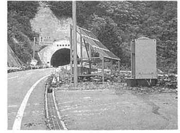
釣瓶トンネル手前
