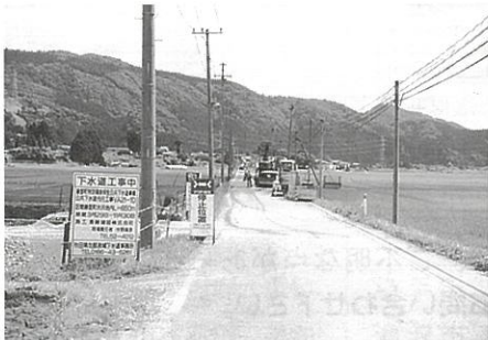
藤琴大沢間の本管工事
