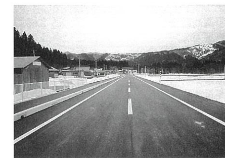
室岱工区が完成した粕毛米田線
