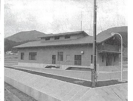
接続工事は中通地区から
