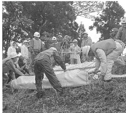
町消防団が取り組んだシート張工法
